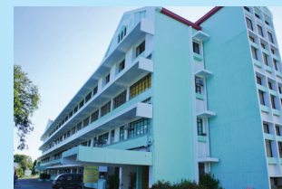
エンジニアリングビル（工学部）
